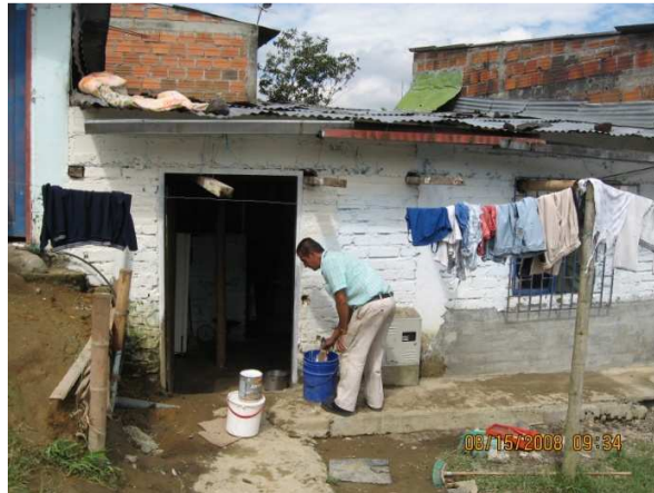
Pintura de fachadas (Antes)
