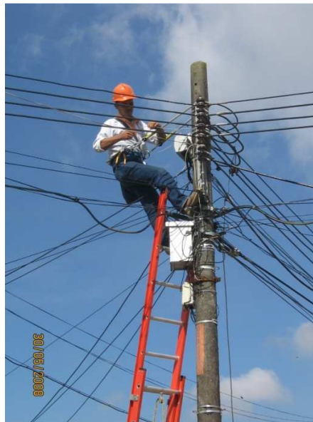
Reparaciones de alumbrado público
